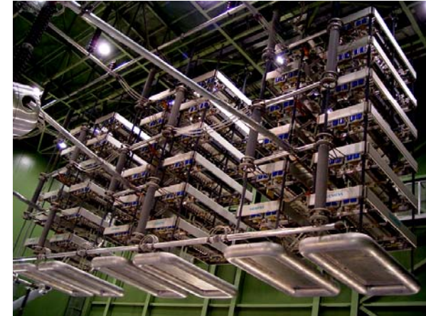
直流输电高压变流阀
